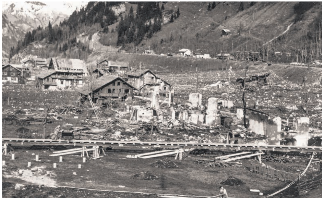
Rechts sind deutlich die gesprengte Fluh und die Schuttmassen zu sehen, davor die zerstörten Gebäude von Mitholz und das verschüttete Bahntrasse.
