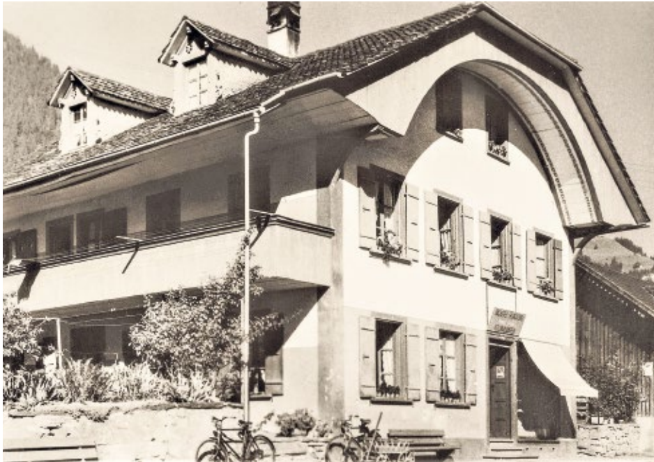
Die Fabrik an der Leischen um 1930 – nun zum Wohnhaus mit Bäckerei umgebaut. Das Äussere des Hauses blieb im Wesentlichen unverändert.
